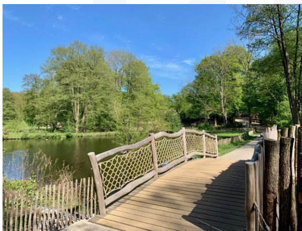
Eine Brücke ersetzt nun den häufig überschwemmten Besucherweg und bietet einen Einblick in das Gehege für Helmkasuarer und einen Blick über die Anlage für Wildvögel.
