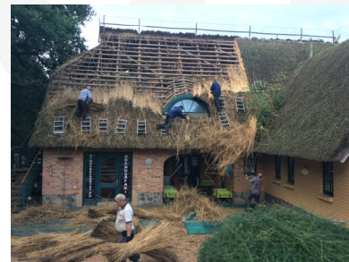
© Zoo Schwerin, Dacheindeckung des Eingangsgebäudes
