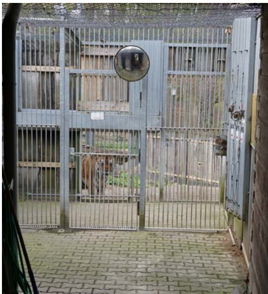
Abb. 4: Nicht voll einsehbare Sicherheitsschleuse mit Spiegel
